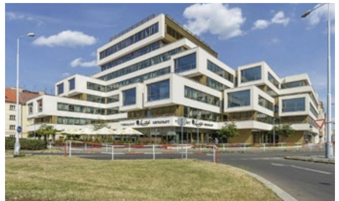
Офисное здание QUBIX, Прага ЧР, 2010 - CoolGRID
