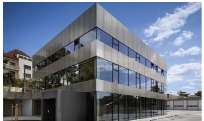
Главный офис компании Komwag Praha ЧР, 2015 - CoolGRID
