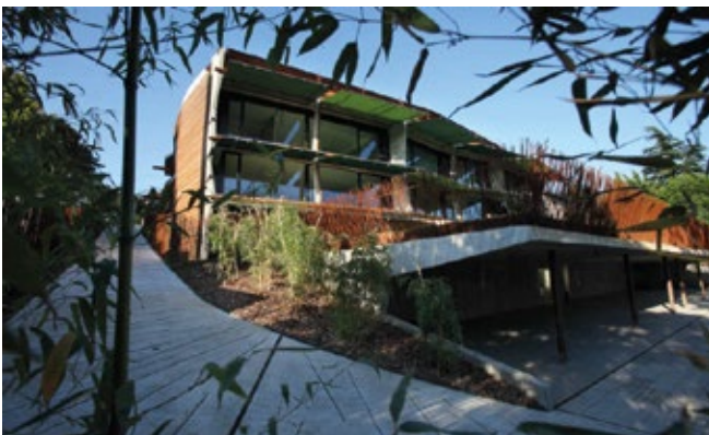
Элитный многоквартирный дом, Белград, Сербия, 2015 - CoolGRID
