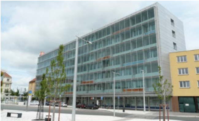
Správní budova ČEZ Hradec Králové CZ, 2006 - CoolPLATE
