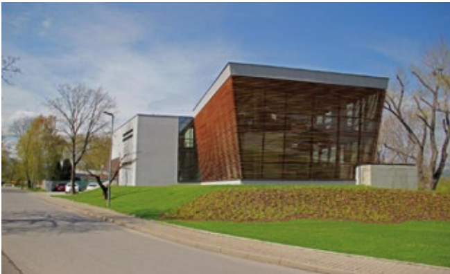
Školící centrum Lovosice CZ, 2016 - CoolPLATE, CoolGRID
