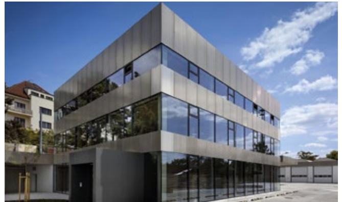
Sídlo firmy Komwag Praha ČR, 2015 - CoolGRID
