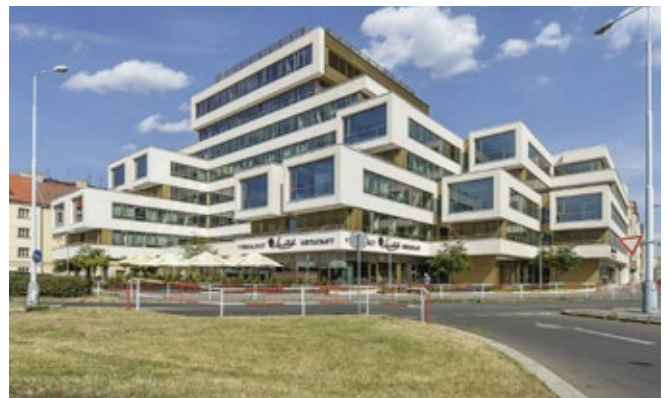
Kancelářská budova QUBIX Praha ČR, 2010 - CoolGRID
